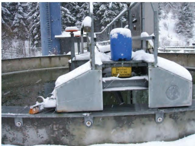
Abb. 1: Der Dosierbehälter fährt auf der Räumerbrücke mit.
