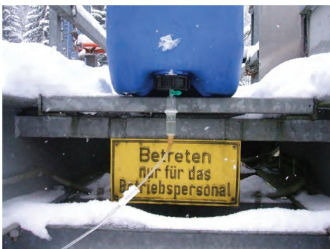
Abb. 2: Die Dosiereinrichtung – einfach und robust
