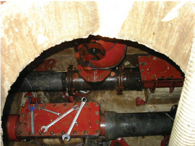
Abb. 4: Auch die Rohrputzöffnung wurde zerstört.
