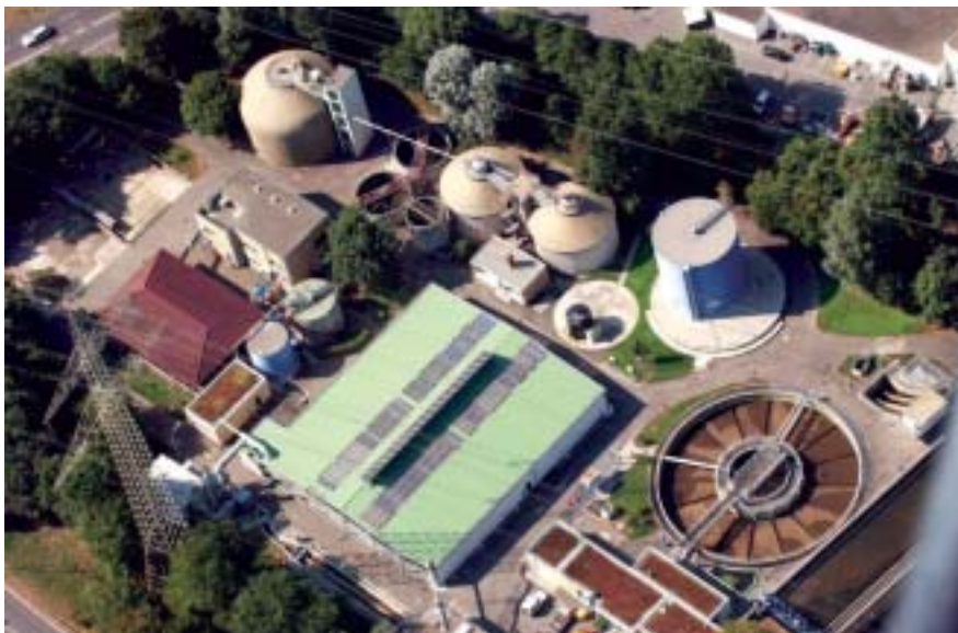
Abb. 1: Das Klärwerk Weinstadt
