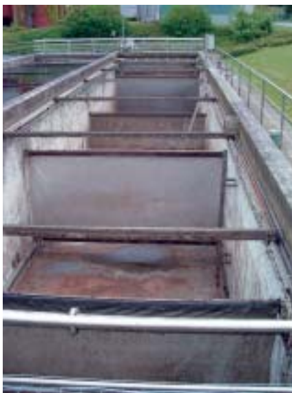
Abb. 1: Nachklärbecken – vorne und in der Mitte die ursprünglichen Folien, die durch zwei weitere Folien ergänzt wurden
