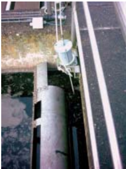
Abb. 3: Skim-Rinne mit Pneumatikantrieb
