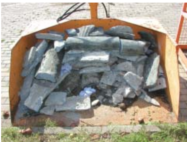
Abb. 1: Massive Ablagerungen in den Leitungen
