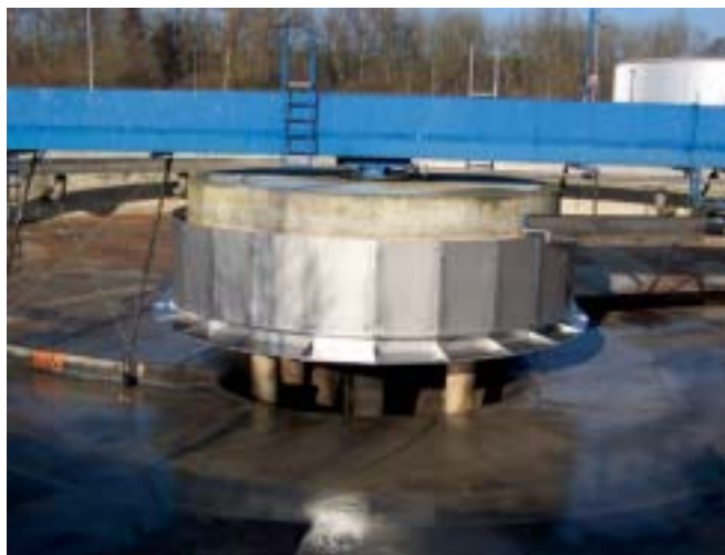
Abb. 2: Zwischenklärung mit umgebautem Einlaufbauwerk
