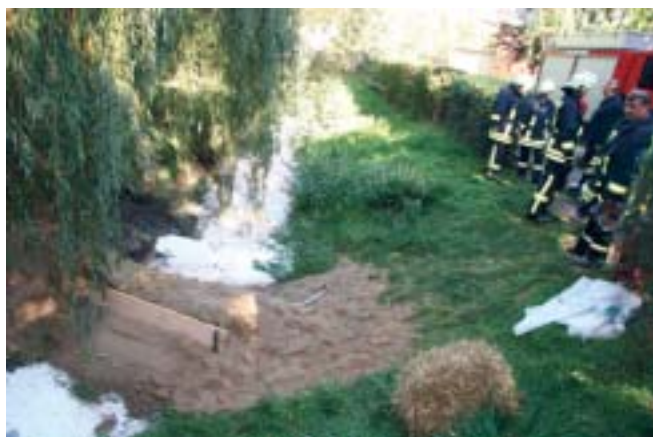
Abb. 5: Das Flüsschen wird durch eine Ölsperre vor Schlimmerem bewahrt
