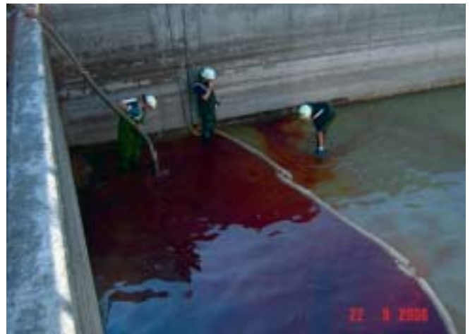
Abb. 4: Die Ölschicht im Becken wird fachmännisch mit Ölsperren abgeskimmt
