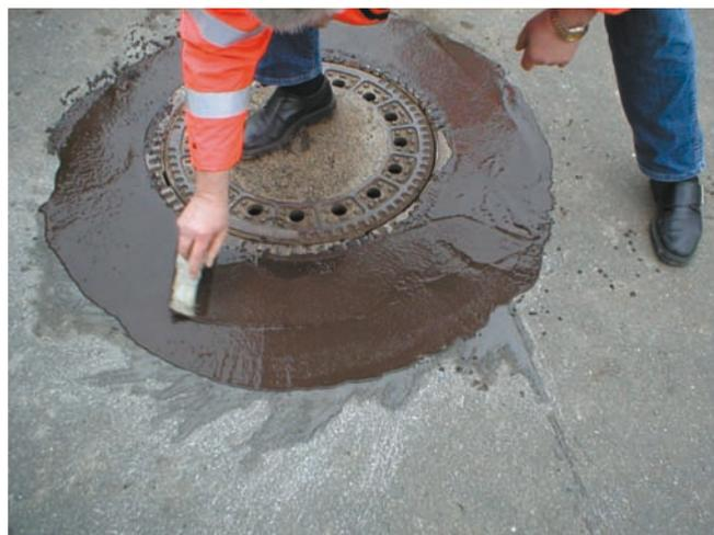
Abb. 8: Verfüllung mit Flüssigasphalt (Hermes Technologie, Schwerte)
