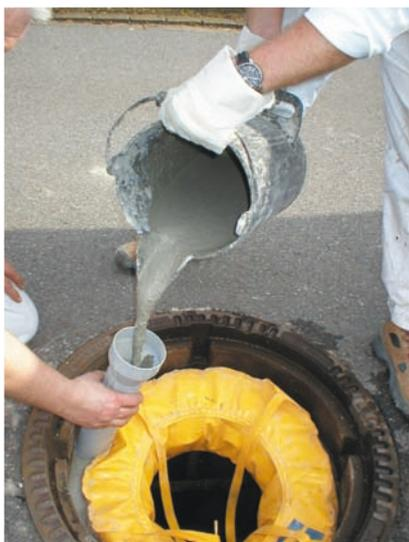
Abb. 7: Regulierung des Schachtrahmens (Hermes Technologie, Schwerte)
