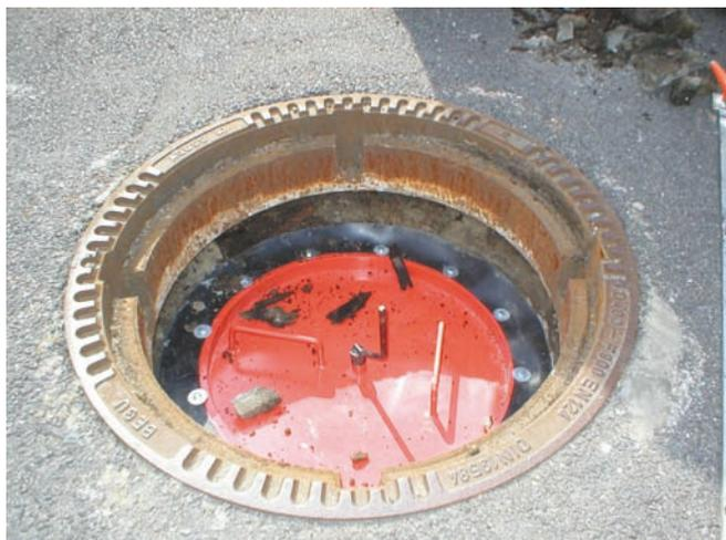
Abb. 9: Schachtabdeckplatte (Hermes Technologie, Schwerte)
