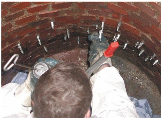
Abb. 12: Setzen von Injektionsdüsen (IKT, Gelsenkirchen)
