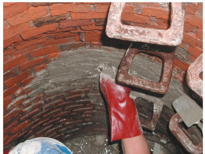
Abb. 10: Abdichten eines Mauerwerks mit Stopfmörtel (IKT, Gelsenkirchen)
