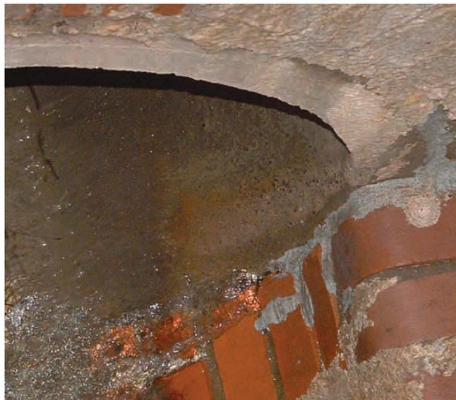
Abb. 1: Undichtigkeiten im Bereich der Einbindung (Foto: IKT)
