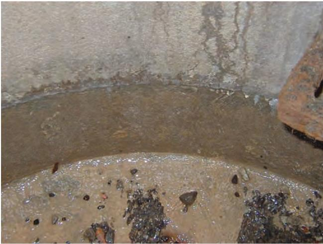
Abb. 2: Undichte Ringfuge in einem Schacht aus Betonfertigteilen (Foto: IKT)
