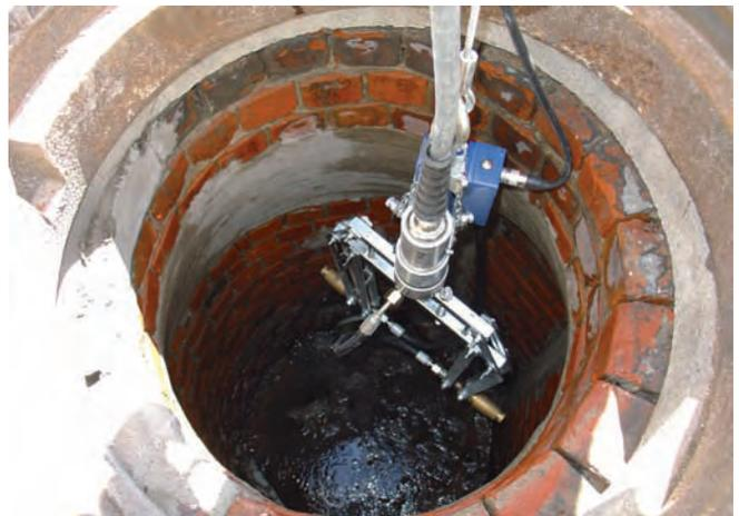
Abb. 4: Reinigung eines Schachts mit Hochdruckspülung (Foto: Hermes Technologie GmbH & Co. KG)
