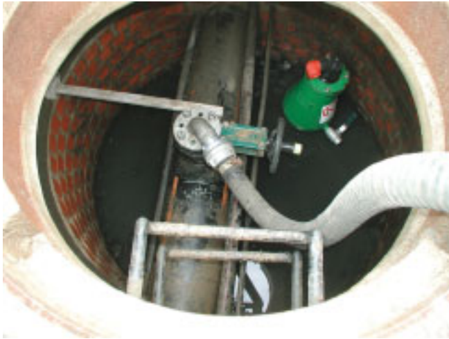
Abb. 1: Einbringen der Luftimpulse in das Abwasserdruckrohr
