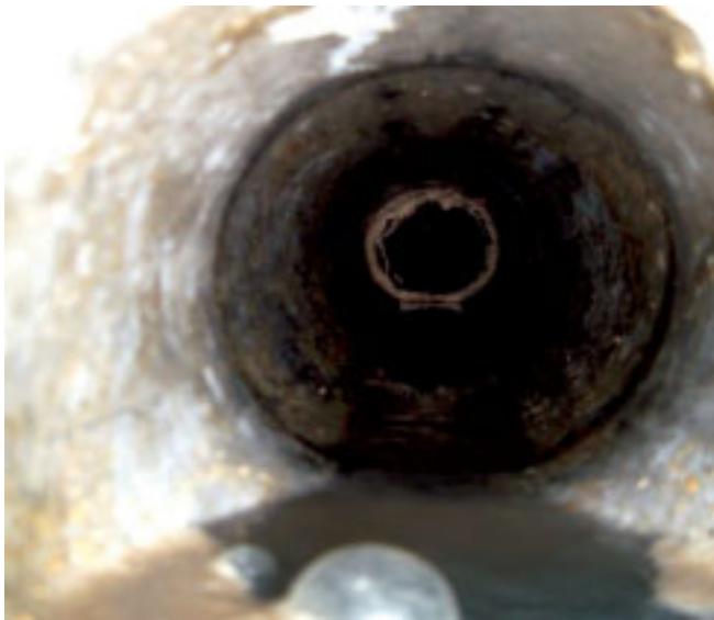
Abb. 4: Rohr frei nach der Behandlung
